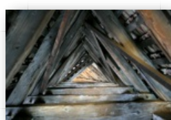
Blick durch das Dach des Wehrgangs.
