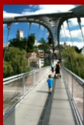
Fußgängerbrücke über die Reuss.
