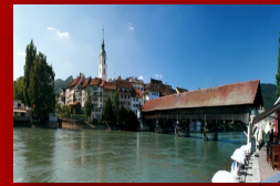
Die historische Holzbrücke in Olten über Aare
