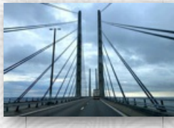
Am frühen Morgen über die Öresundbrück nach Schweden.
