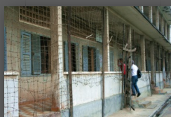
Mit Stacheldraht vergitterte Schulgebäude.
