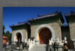
Eingang zur Echowand,
