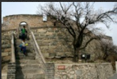
Zugang zur Mauer von der Seilbahnstation.
