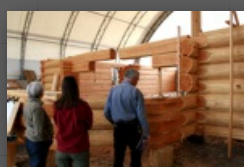
Das nächste Blockhaus entsteht beim Loghouse-Builder
