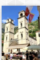
Die Kathedrale von Kotor umgeben von Restaurants.
