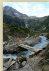
Provisorische Brücke im Tal der Sulzenau Alm.
